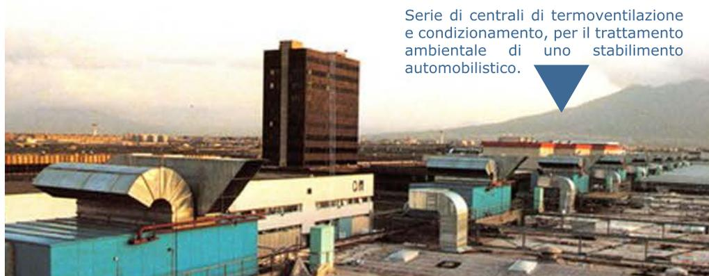
Serie di centrali di termoventilazione e condizionamento, per il trattamento ambientale di uno stabilimento automobilistico.
