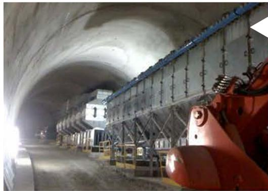
Centrale di aspirazione e filtrazione per polveri altamente pericolose, installato in galleria, volume d'aria trattato 215.000 mc/h, costituito da una sezione prefiltrante a cartucce con efficienza 99,99% con particolato  $\geq 0,5$  micron, e completo di controlavaggio automatico, da una sezione postfiltrante tipo assoluto Poliedrico HEPA con classe di filtrazione: H13-EN1822.
