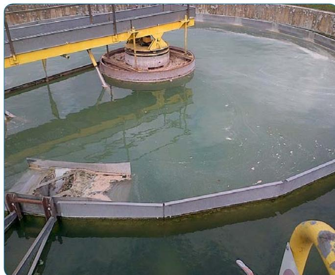
Figura 2 | Sedimentatore dopo due settimane di trattamento.
