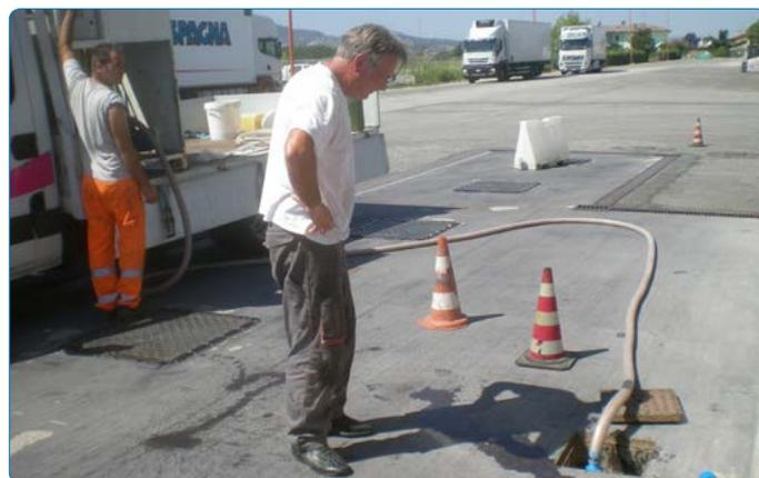
Figura 3 | Inoculo bioattivatore-nutriente tramite tubi piezometrici micro-fessurati.
