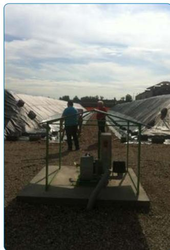
Figura 5 | Le biopile ed in primo piano una delle due soffianti.
