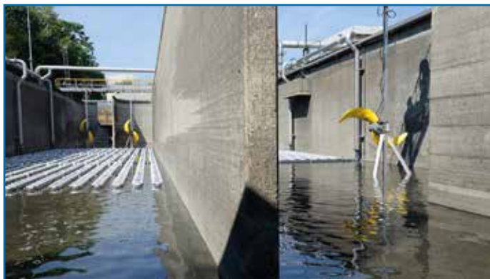
Figura 9 – La particolare struttura dell'impianto è stata simulata anche via software per ottimizzare ogni singola scelta.
