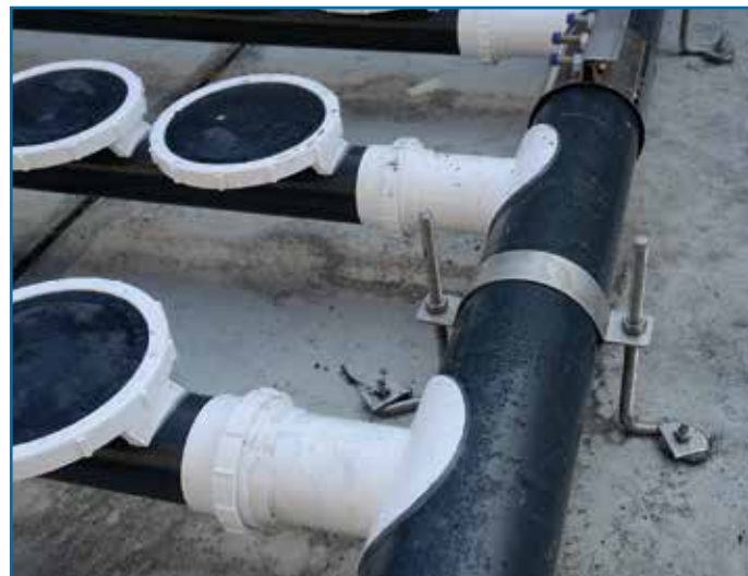
Figura 4 – La cura nella realizzazione dei diffusori consente di posizionare le apparecchiature in tempi rapidi e senza problemi in fase di test finale.
