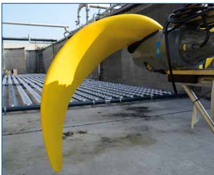
Figura 7 – Il particolare profilo delle pale dei mixer 4410, usate da Lariana Depur nella denitrificazione, permette di ottenere una notevole spinta, pur operando a basso numero di giri.
