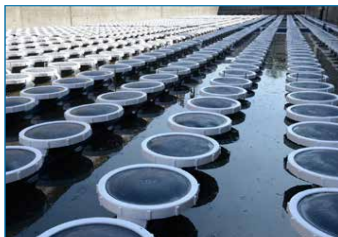
Figura 6 – Le microbolle prodotte dai diffusori Sanitaire massimizzano l'efficienza del processo di ossidazione.
