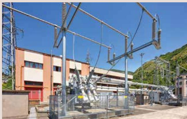
alta tensione PASS ed i pannelli di controllo e protezione – in una singola unità multifunzionale e compatta.
